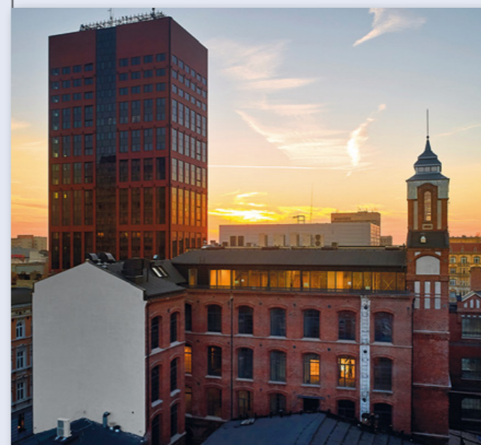
Sepia Office w budowie
