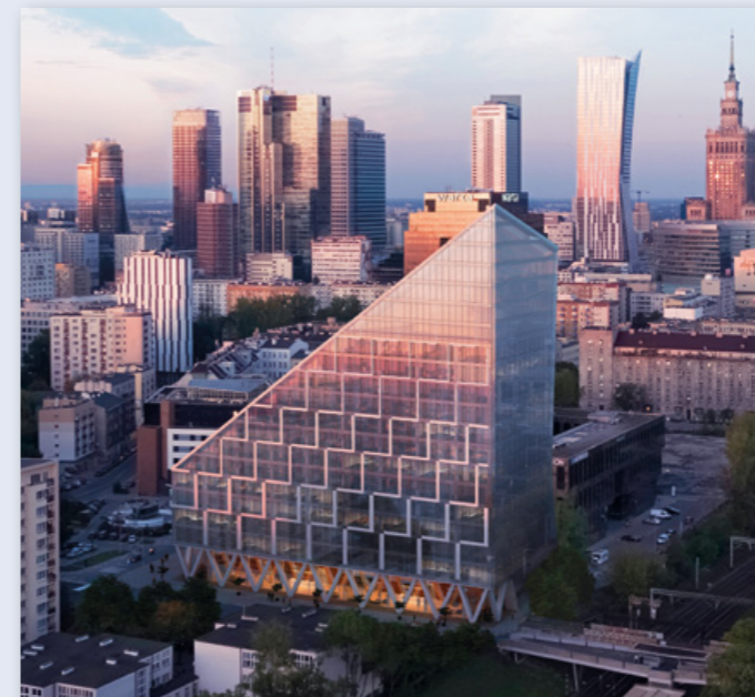
Chmielna 89 w budowie
