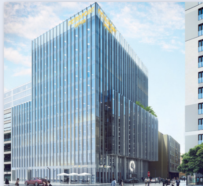
Metropoint Office w budowie
