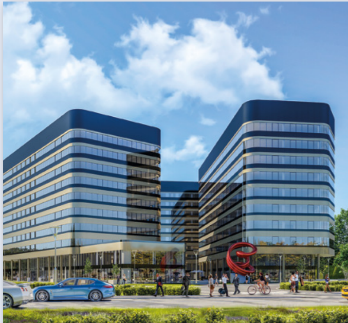
Fabryczna Office Park budynek B1 – oddany budynki B2 i B3 – w budowie
