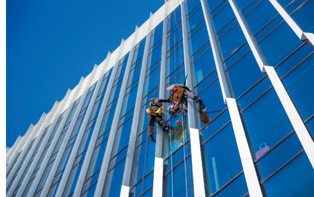
Instalacja paneli perowskity na fasadzie biurowca Spark
