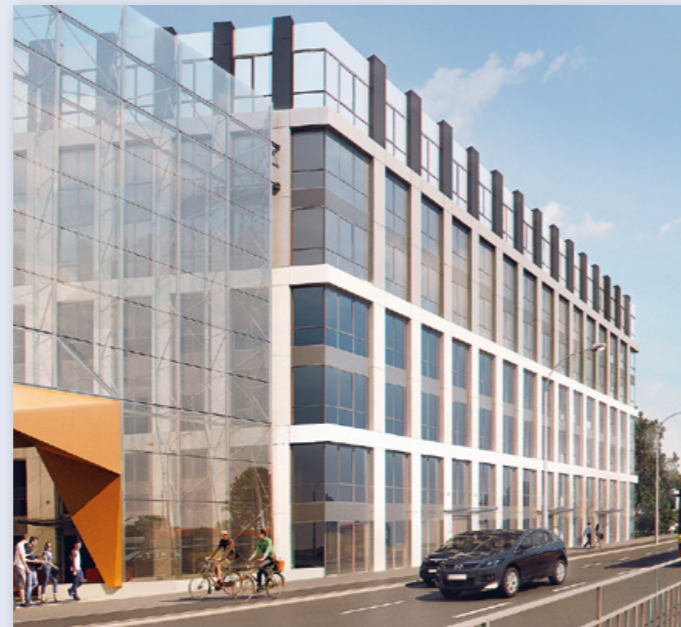
City Forum w budowie
