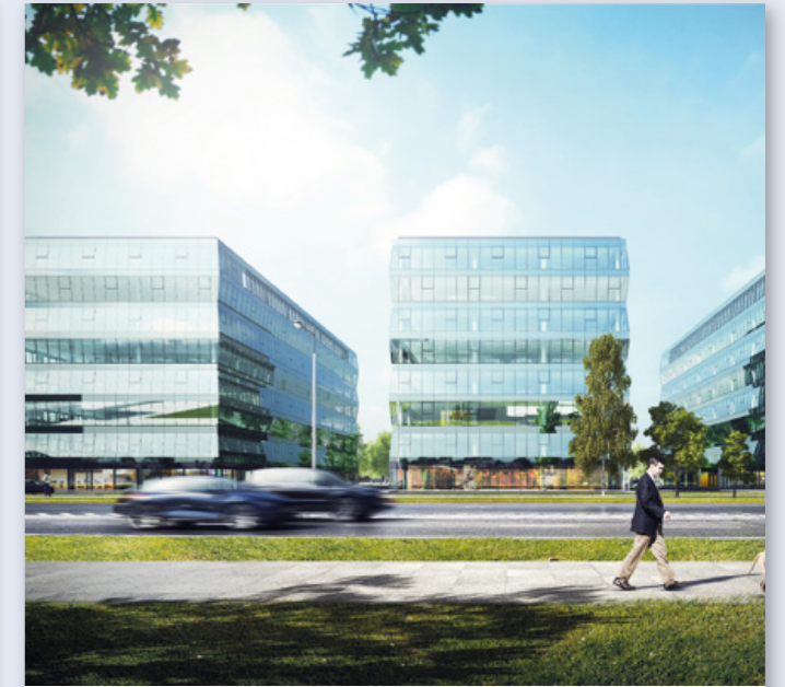
Wadowicka 3 I etap – oddany II etap – w budowie III etap – w planach
